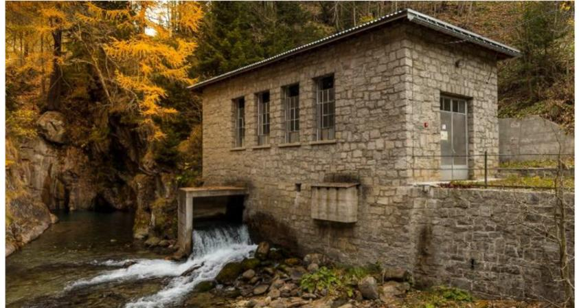
Im Spätsommer 2011 wurde das KW Binn umfassend erneuert. Insbesondere wurde die elektromechanische Ausrüstung inkl. Turbine ersetzt sowie die Wasserfassung mit Entsander saniert. Die Rhowag hat für die Erneuerung die Unterstützung durch die kostendeckende Einspeisevergütung (KEV) beantragt und zugesprochen erhalten.
